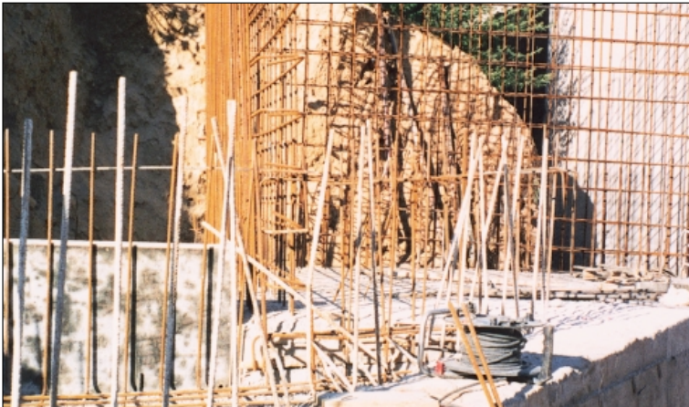
Estructura de l'obra
